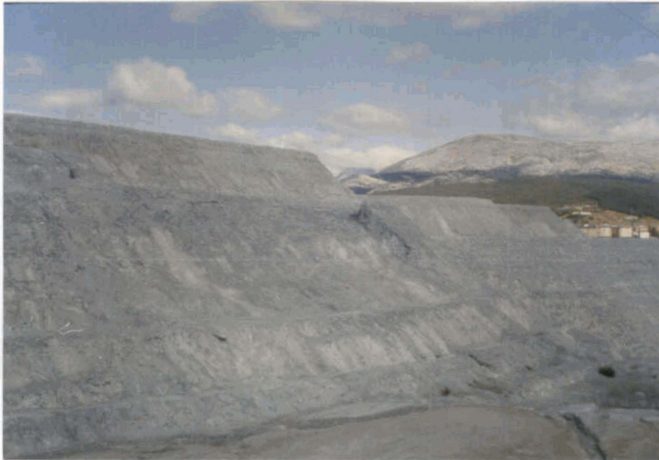
FOTO 7.2.- DESESTABILIZACION DEL DIQUE DEL DEPOSITO, CON ESCAPE EN COLADA DEL MATERIAL. FABRICA DE - DERIVADOS VINILICOS DE E.R.T., S.A. EN GUARDO.
