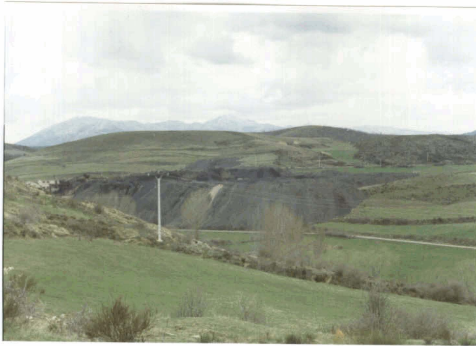
FOTO 5.2.- VISTA GENERAL DE ESTRUCTURAS EN LA ZONA DE SAN CEBRIAN
