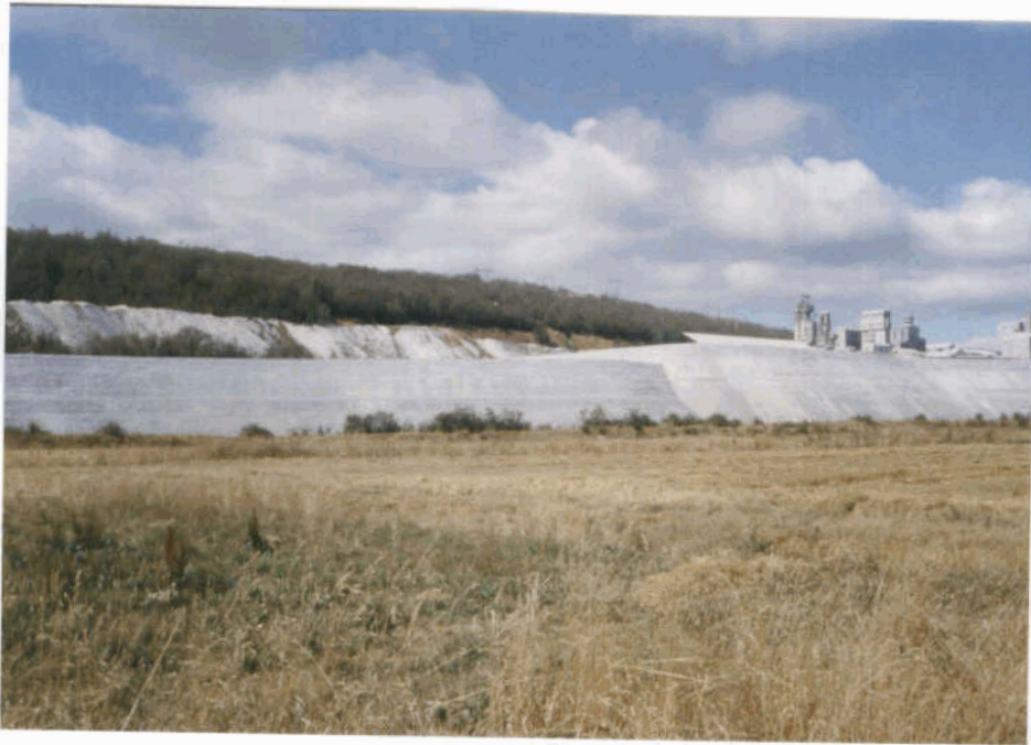
FOTO 7.1.- BALSAS DE HIDROXIDO CALCICO DE LA FABRICA DE DERIVADOS VINILICOS DE E.R.T., S.A. EN GUARDO
