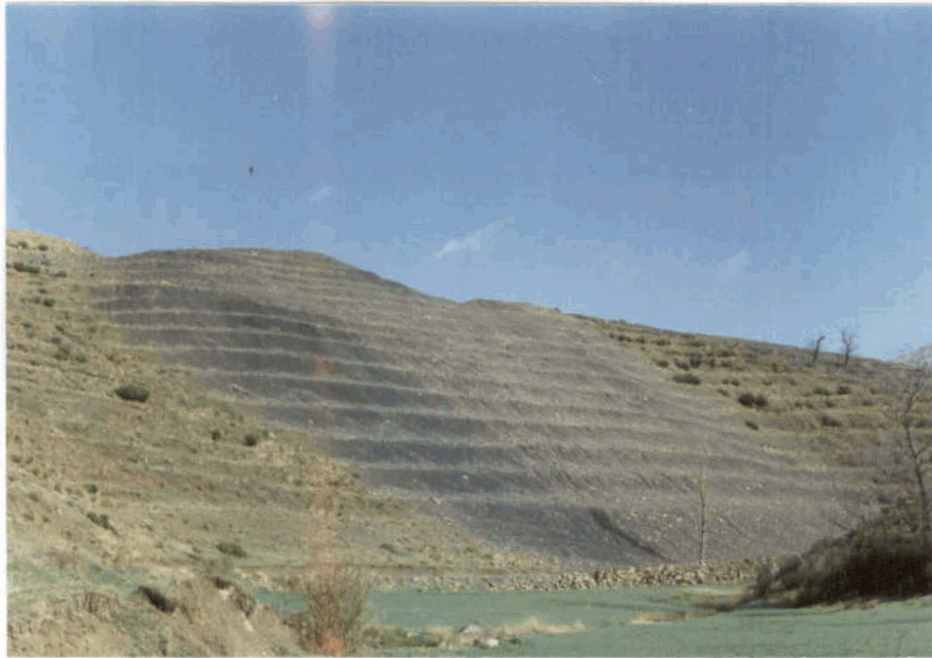
FOTO 11.1.- RESTAURACION DE LA ESTRUCTURA DE VILLANUEVA DE ARRIBA DE LA COMPAÑIA MINERA DE SAN LUIS
