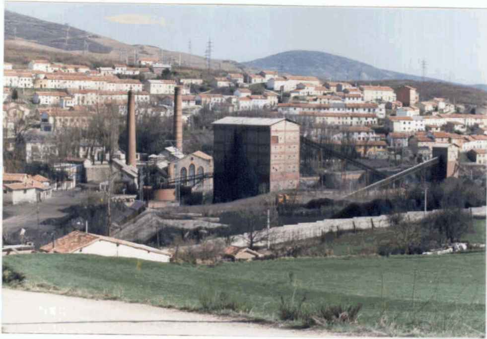
FOTO 5.3.- LAVADERO DE HULLAS DE BARRUELO Y SU PARQUE DE CARBONES
