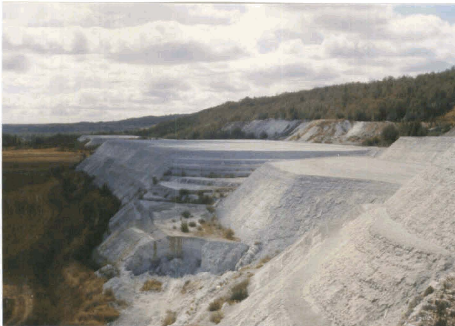
FOTO 10.1.- EXPLOTACION ACTIVA A CIELO ABIERTO EN HULLAS DE BARRUELO
